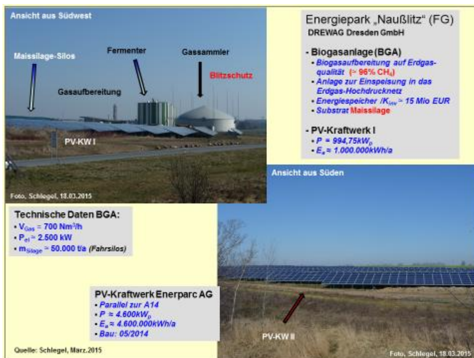
Abb. 11: Energiepark „Naußlitz“, Roßwein (FG)
