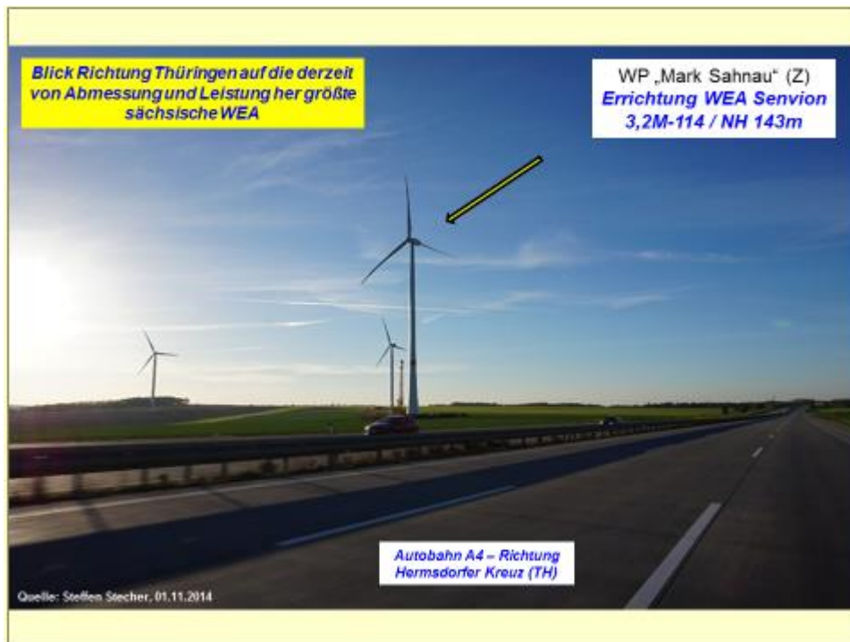
Abb. 8: Errichtung der leistungsstärksten WEA im WP „Mark-Sahnau“, (Z)
